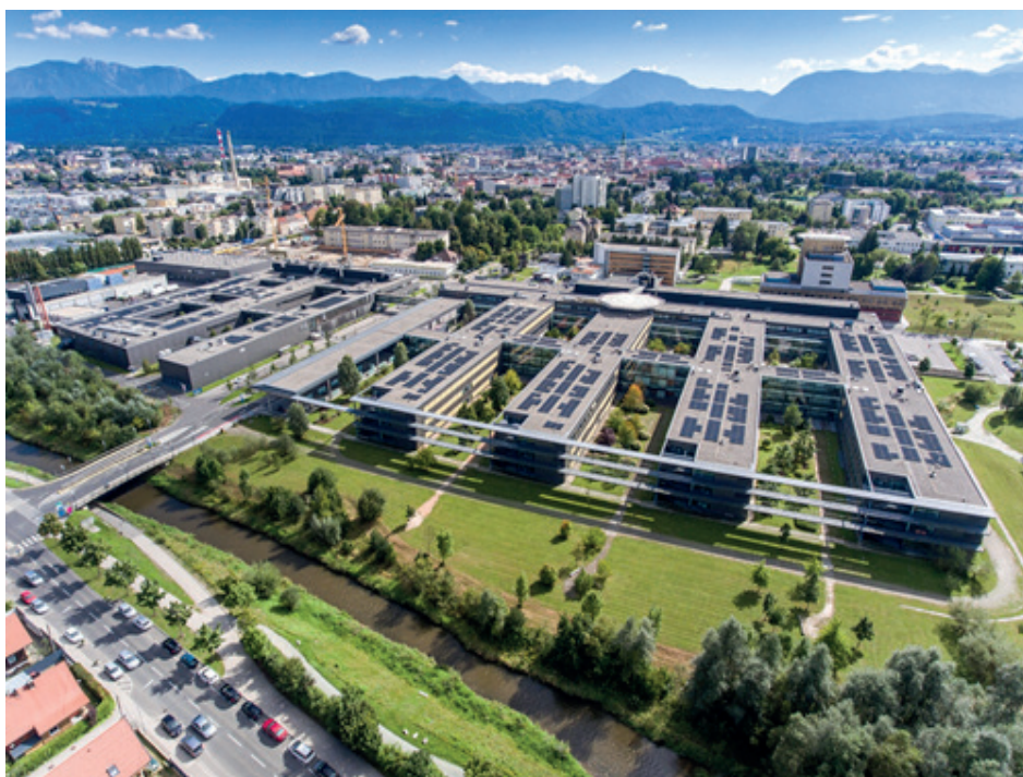
Photovoltaikanlagen am Standort Klinikum Klagenfurt
