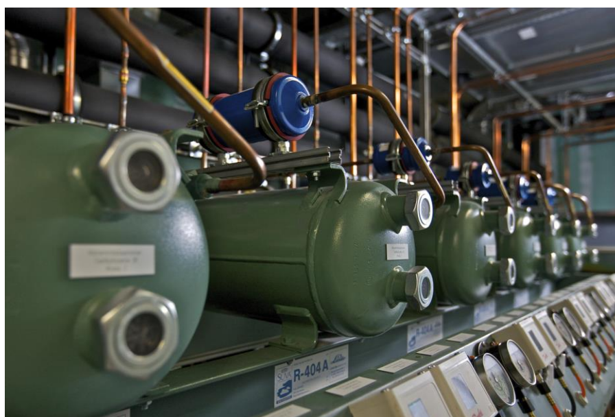
Bild 3: Kälteanlage Klinikum Klagenfurt
