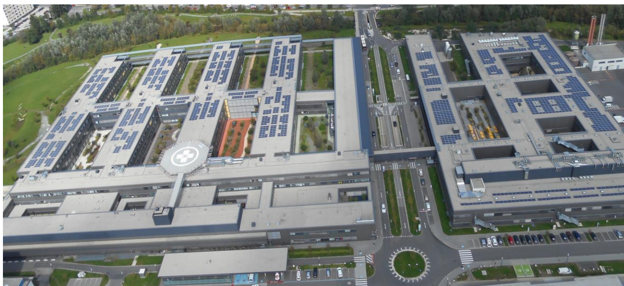
Bild 2: PV Anlage 570 kWp Klinikum Klagenfurt
