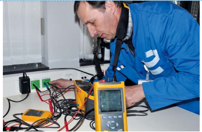
Laufende Kontrolle: Elektriker bei der Netzanalyse.
