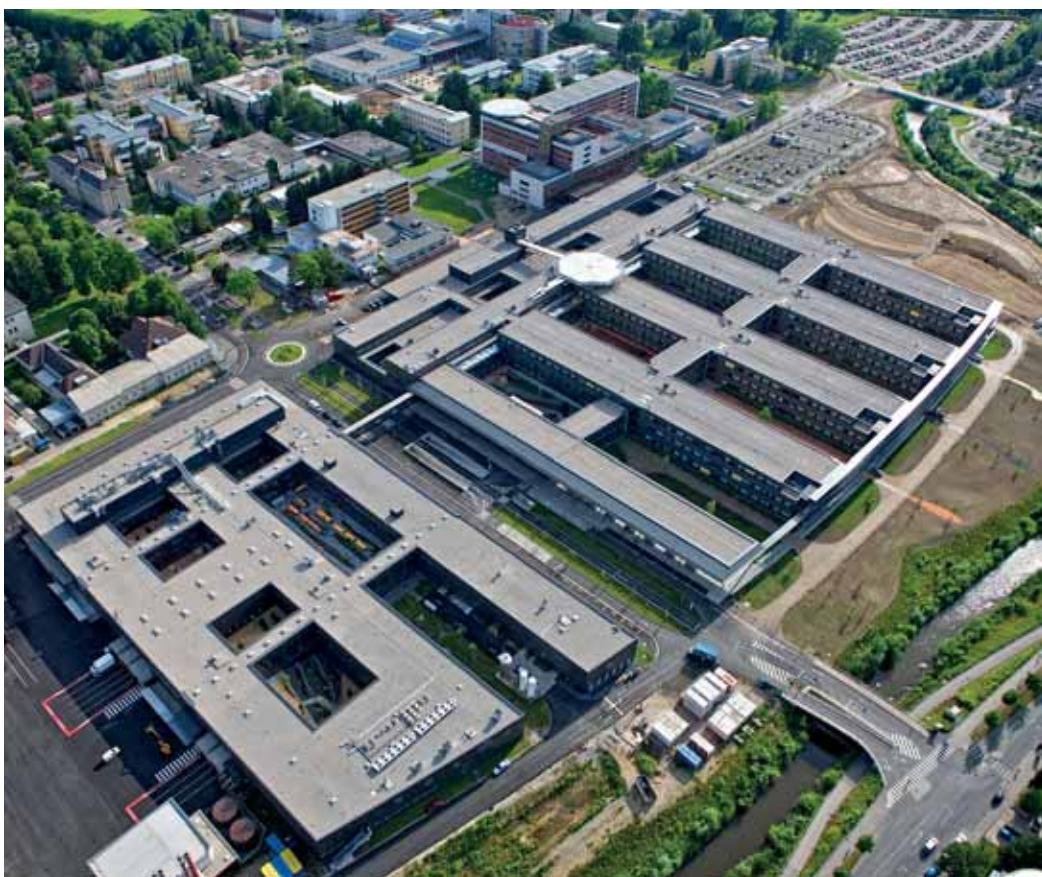
Das Klinikum Klagenfurt am Wörthersee wurde mit dem „Green“-Building-Award ausgezeichnet
